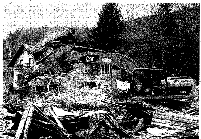
Heute: 23 Häuser in Gloggnitz werden dem Erdboden gleich gemacht
